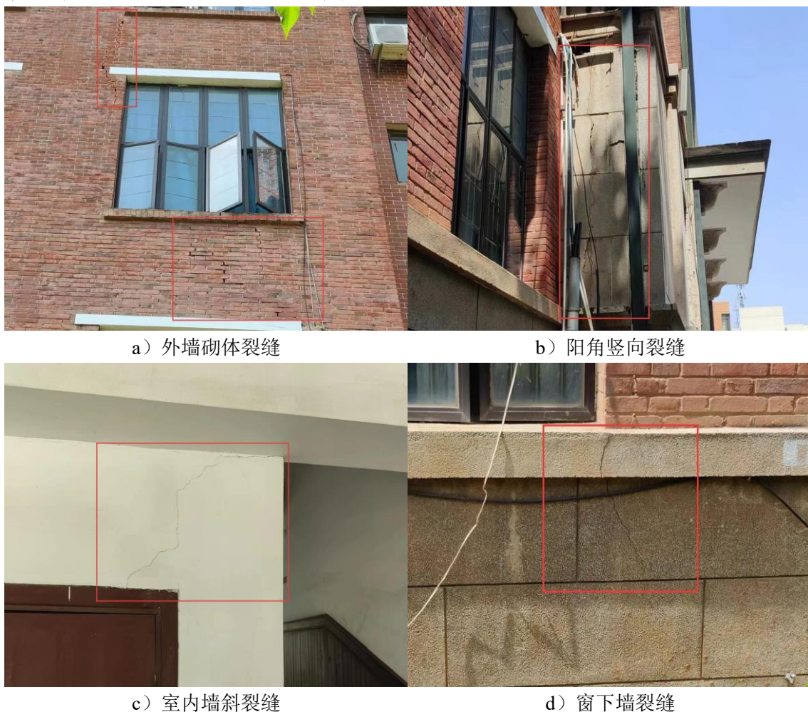
图 4.15 示例建筑③实地勘探情况
