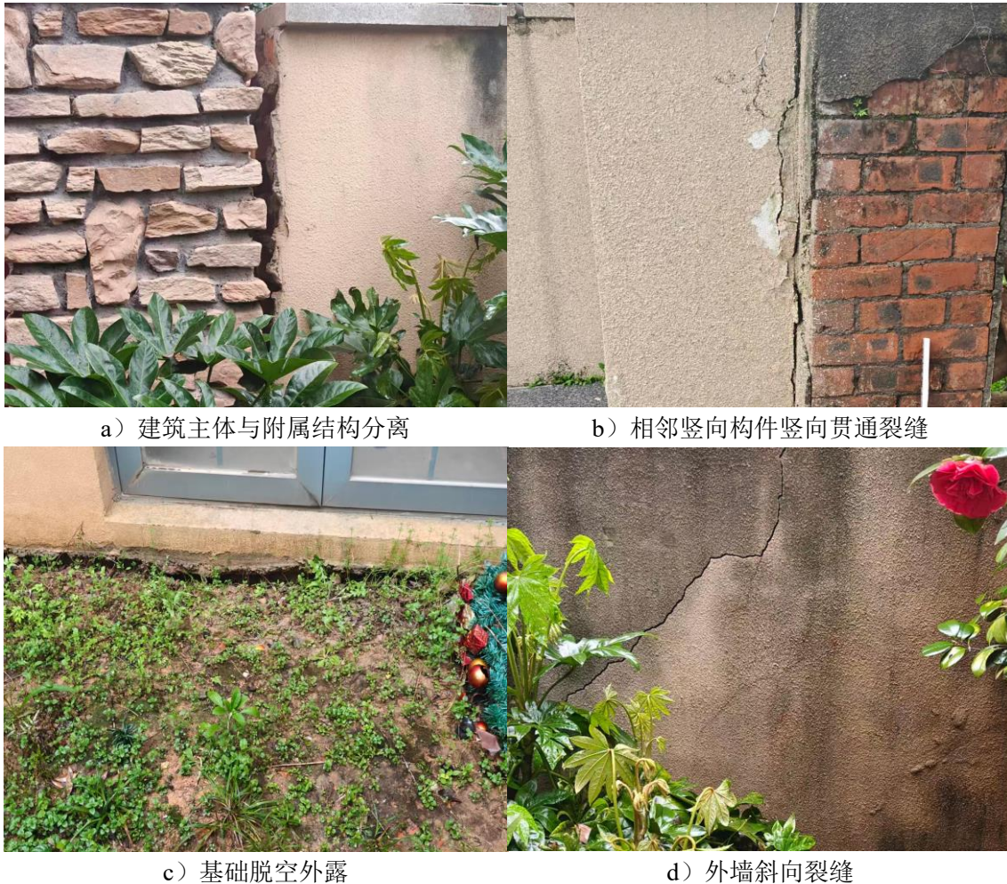
图 4.13 示例建筑①实地勘探情况
