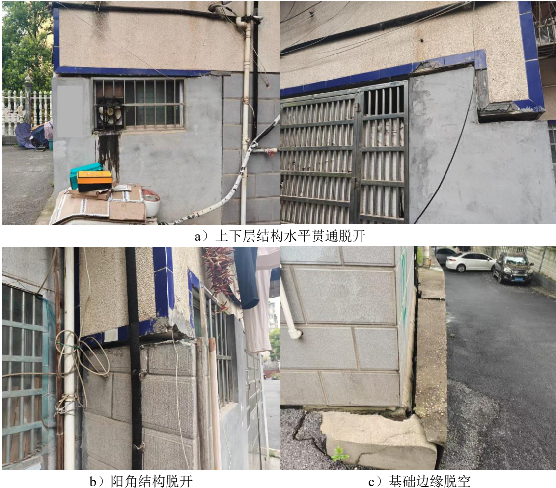
图 4.14 示例建筑②实地勘探情况
