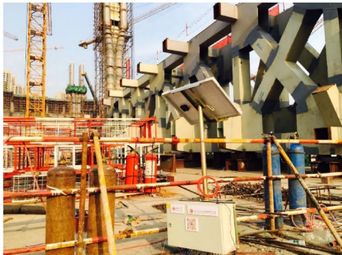
(b) 格构柱处自动化采集装置
