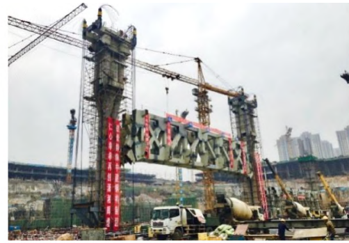
(a) 吊装过程
