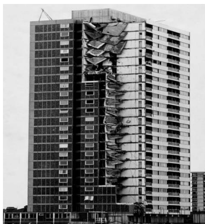
图 1.1 英国Ronan Point 住宅发生倒塌事故 [6]
