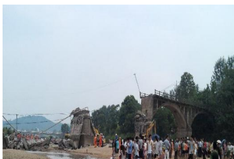
a) 江西广昌河东大桥发生倒塌
