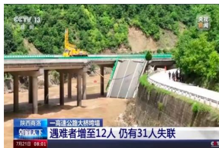
d) 陕西柞水大桥垮塌
