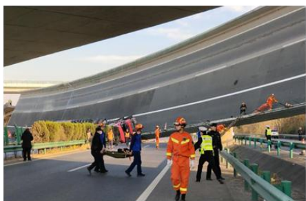
c) 湖北高速桥发生垮塌
