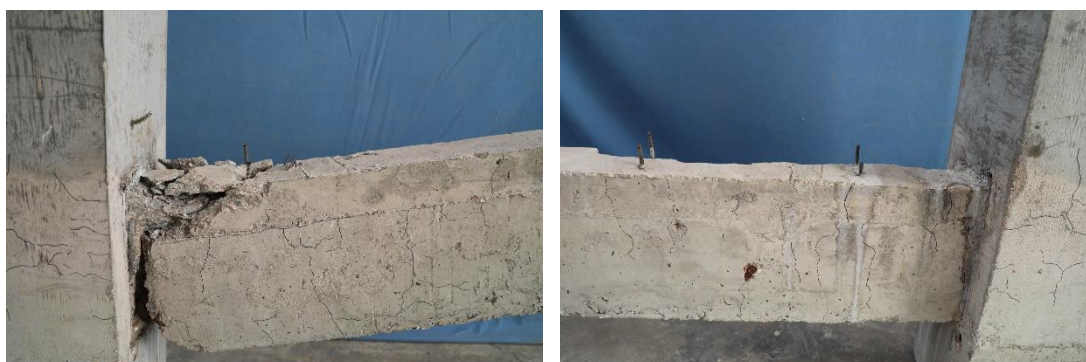
b) 北侧梁柱连接处
