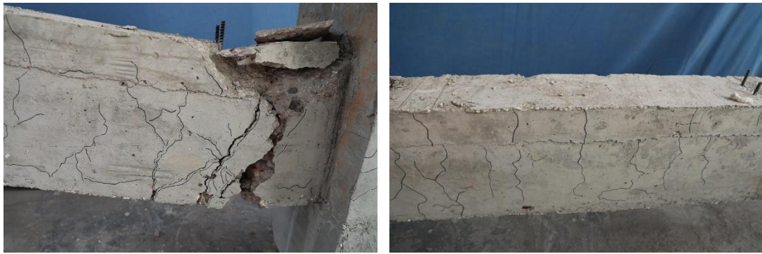
b) 南侧梁柱连接处
