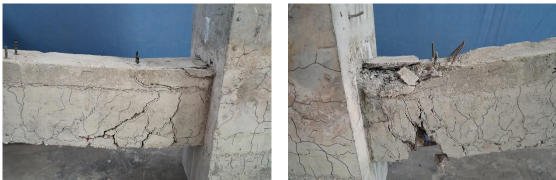
b) 南侧梁柱连接处
