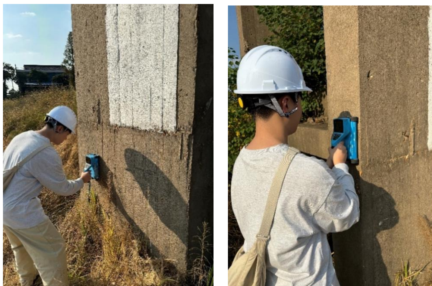
图 5.10 混凝土保护层厚度检测过程
