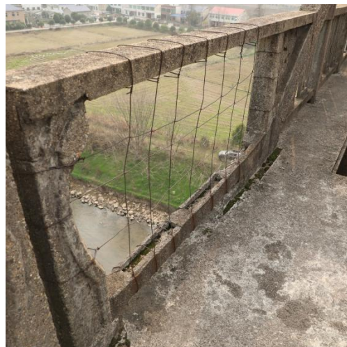
d) 护栏脱落示意图
