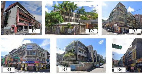
图 17 建筑实景图像
