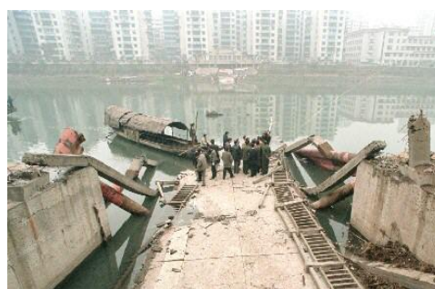
b)彩虹桥垮塌事故现场
