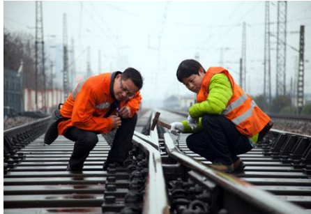
a) 人工敲击铁轨判断损伤
