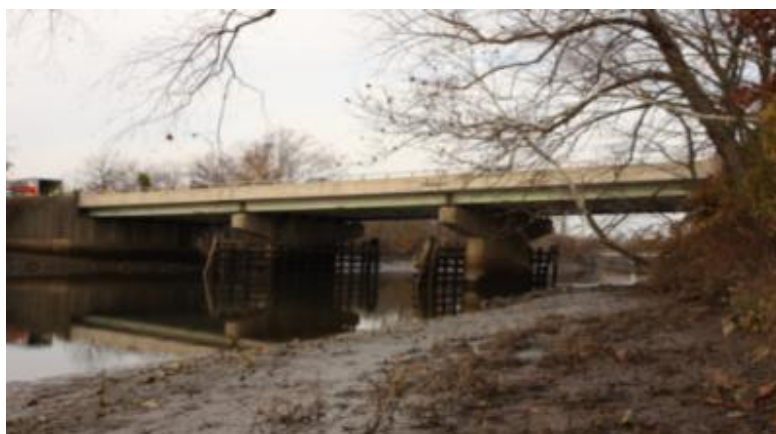
a) 测试桥梁
