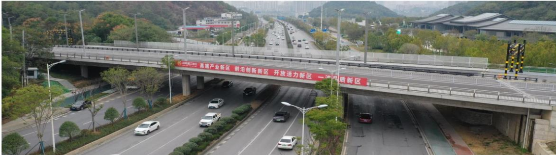
a) 桥梁现场
