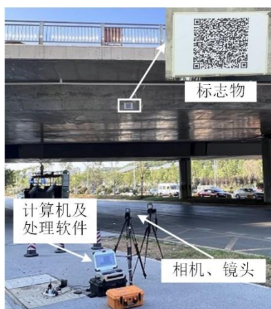
图 2.1 基于 DIC 法的结构位移测量系统
