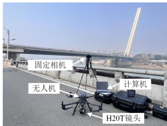
图 4.12 野外试验测量系统
