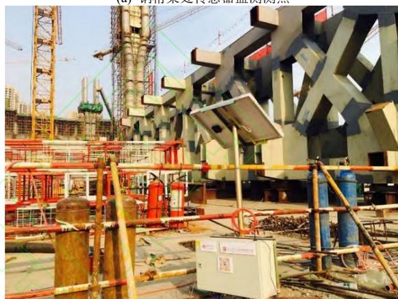
(b) 格构柱处自动化采集装置
