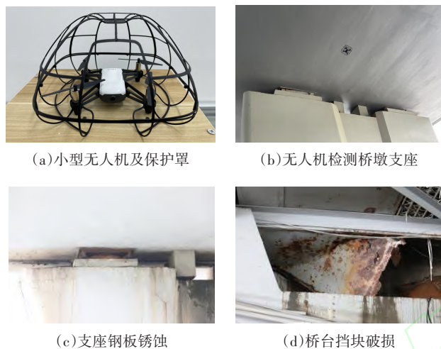
图8 桥梁外观质量检查
