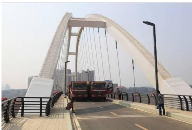
图 3.1 成桥实验
