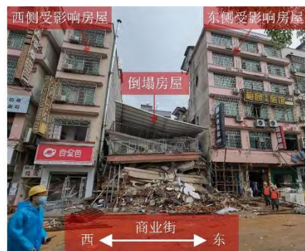
图4 房屋倒塌后状态
