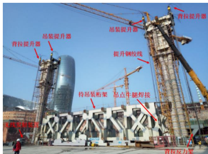
图 6.4 大跨重型钢桁架吊装施工案例
