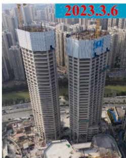
(d) Current construction progress
