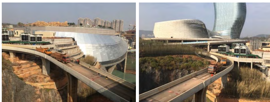
c) 现场测试全景(视角一)
