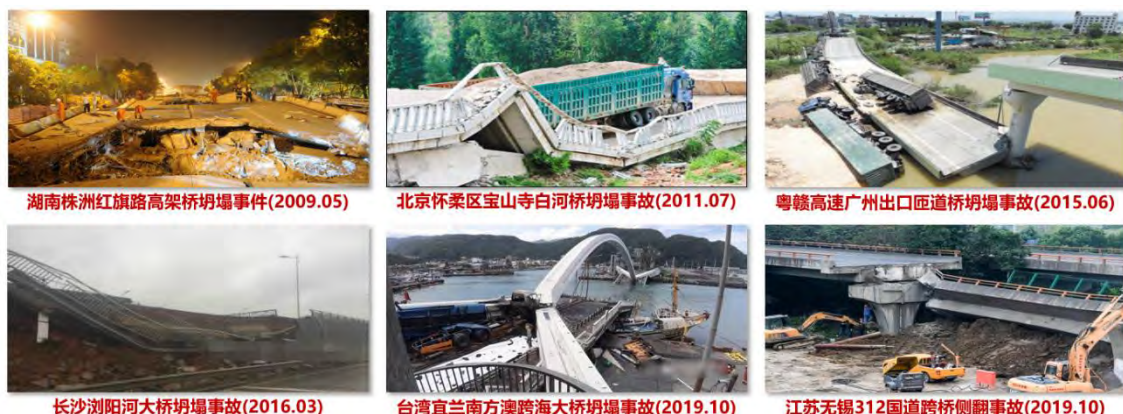
图 1.1 桥梁垮塌事故案例
