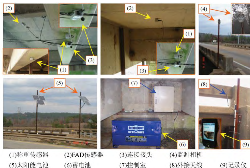
图 1.4 桥梁动态称重系统现场安装情况
