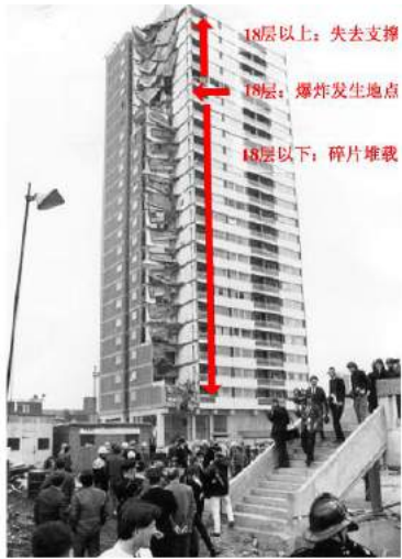
图 1.1 Ronan Point 公寓倒塌事故 [7]
