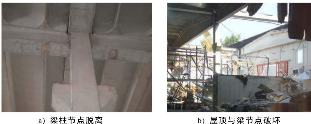
图 1.3 装配式混凝土结构节点破坏
