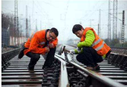
a) 人工敲击铁轨判断损伤
