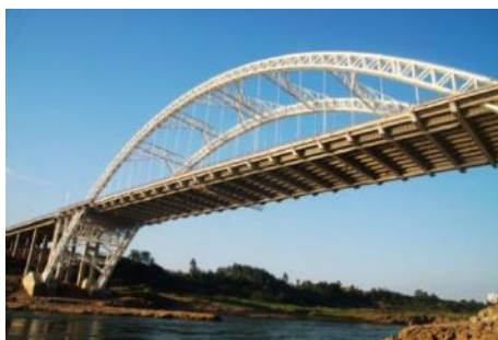
图 4.2 来华大桥照片 [84]
