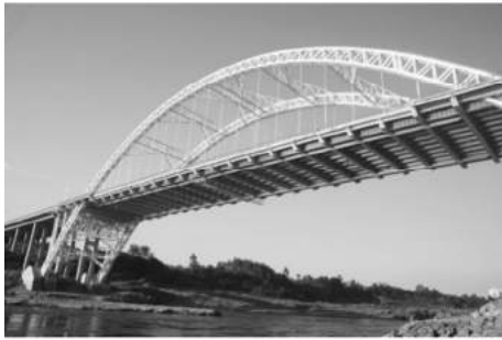
图 2 来华大桥照片 Fig. 2 Picture of Laihua Bridge
