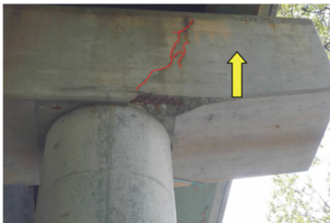
图13 盖梁裂缝
